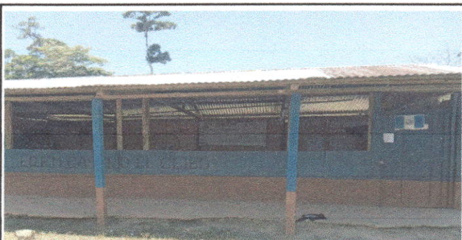
Foto 5: Mantenimiento de las aulas.
