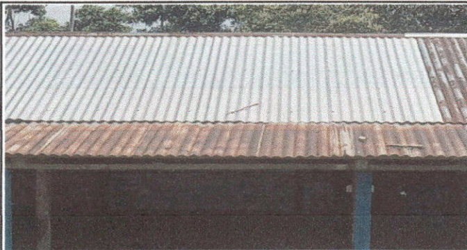
Foto 3: Cambio de techo
