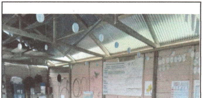
Foto 6: Cambio de estructura de Techo
