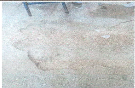
Foto 4: Reparacion de piso
