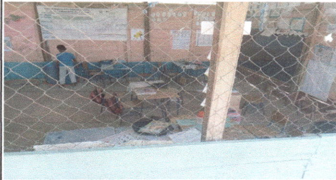
Foto1: Cambio de ventanas
