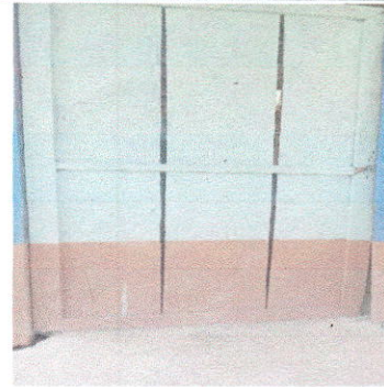
Foto 2: Cambio de puerta a metal
